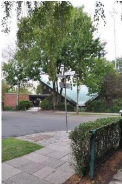
Bemerkenswert ist auch die St.-Lukas-Kirche in Grolland. Ihr Dach besteht aus zwei halben Ellipsen, die durch Drahtseilne (Daniel Gehrmann)
